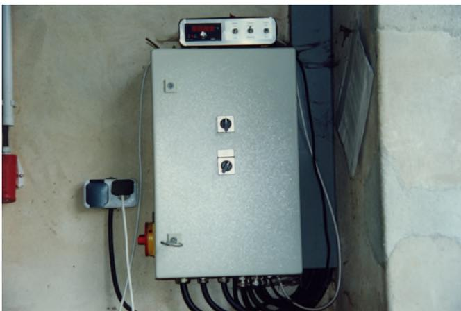
**Steuerungsanlage Wechselschaltung und Frostwarngerät**
